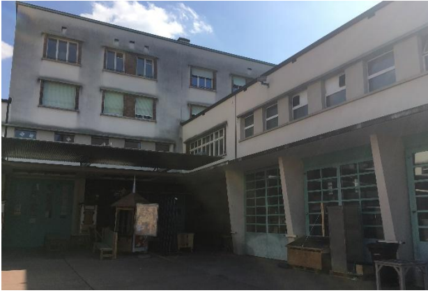
Abb 6: Der Innenhof der Kaserne.
