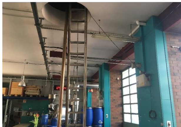
Abb 5: Feuerwehrrängen im Restaurant Löscher.
